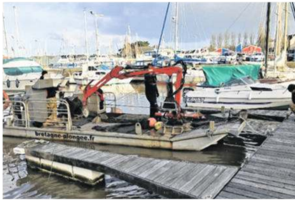
L'équipe surveille le plongeur qui œuvre sous le ponton.
