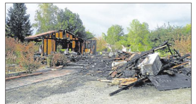
La maison entièrement détruite.
